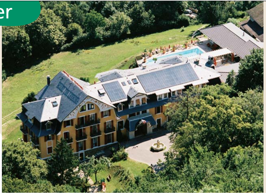
90 m 2 de panneaux solaires ont été installés sur le toit de l'hôtel à la fin de 2004.
